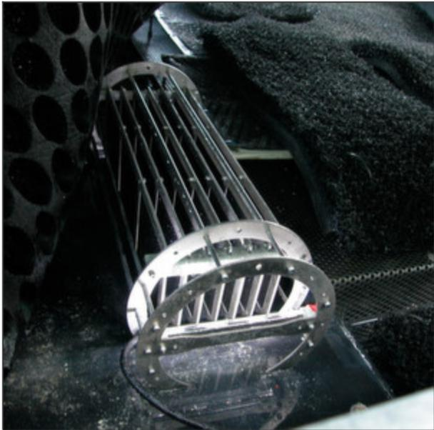
Modul mit Metall-Mineral-Folien in einer Kühlturmzelle verhindern mikrobiologisches Wachstum. (Bild: Mol Katalysatortechnik)
