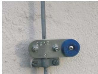
Kennzeichnung von Schächten zum Nachweis der Überprüfungsintervalle nach SüwKan/EKVO
